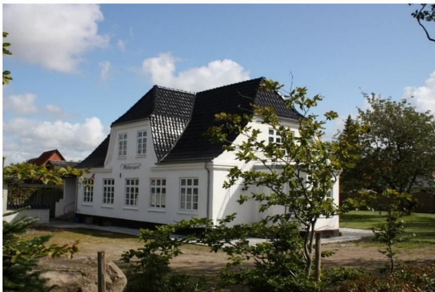
Mellergård i renoveret stand 2009
