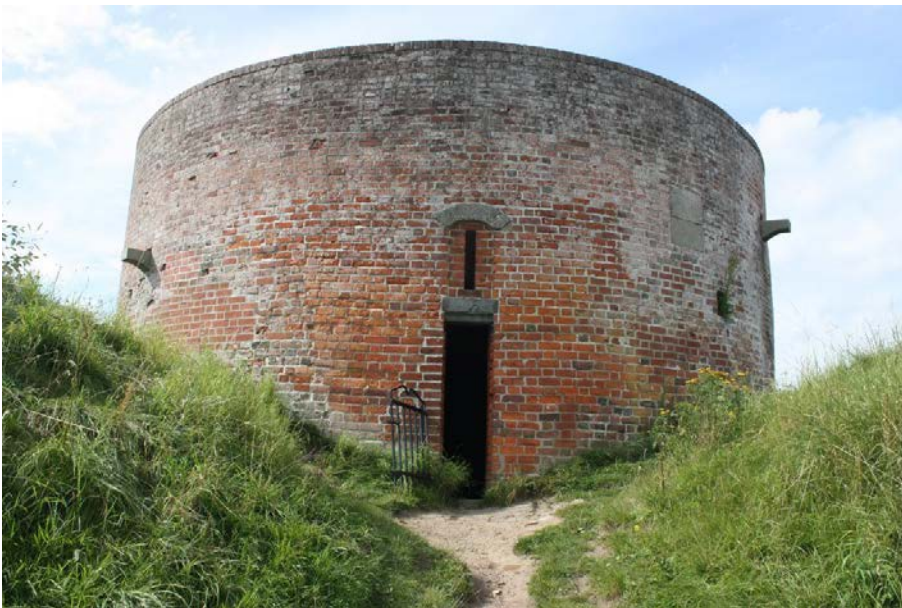
Efter at Christoffer Krabbe havde restaureret tårnet og forhøjet det med en etage og et nyt tag, som omkring 1929 blev nedrevet, fik tårnet det nuværende udseende som "vandtårn". Set fra øst. Eget foto. 2016. I Niels Bugges tid gik volden ikke op til indgangen, man skulle bruge en 4-5 meter lang stige.
